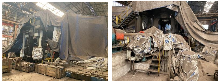
Fig.17: Instalación de carpas y envolturas.
